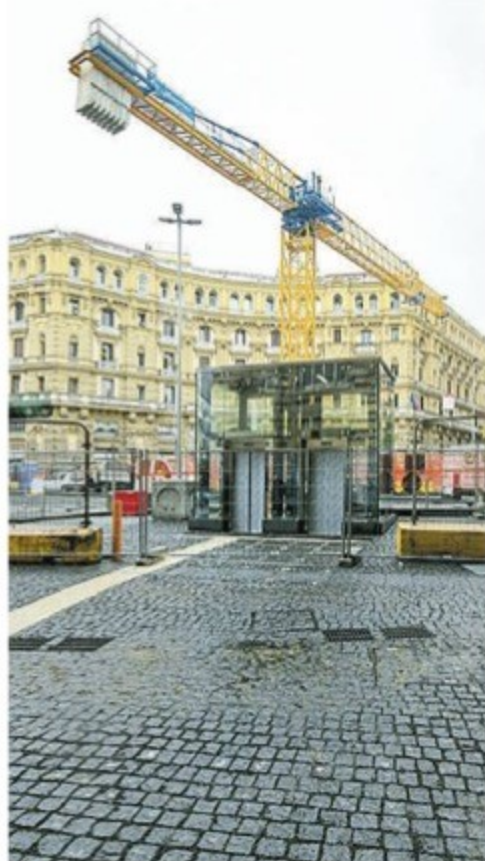
▲ I lavori Una parte del cantiere che ancora resta in via Duomo
